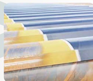
鋼管パイプ重防食塗装
